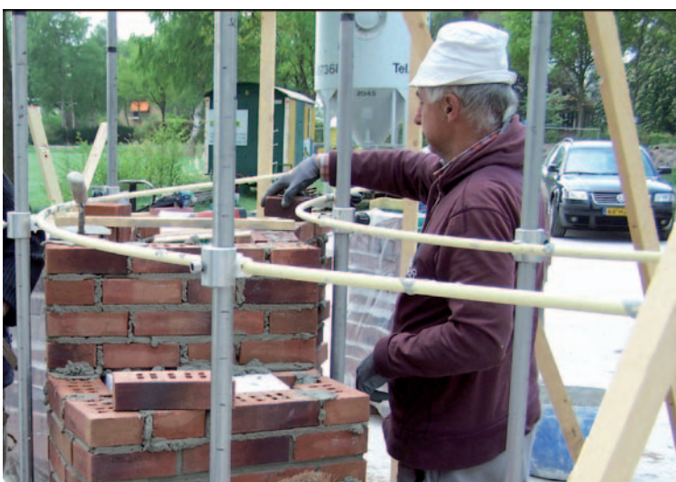
Bij 'De Muur Tegen Geweld' in Wolden is een systeem met kunststof elektrabuizen ingezet voor de realisatie van gebogen metselwerk.
