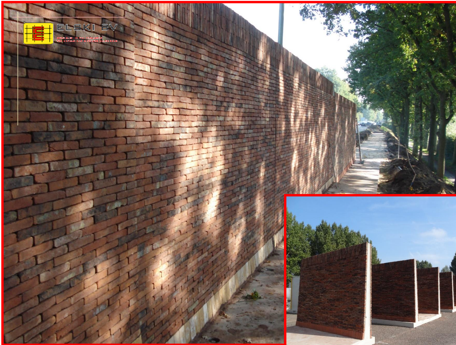
300m Geluidsscherm van prefab elementen N317 te Doesburg
