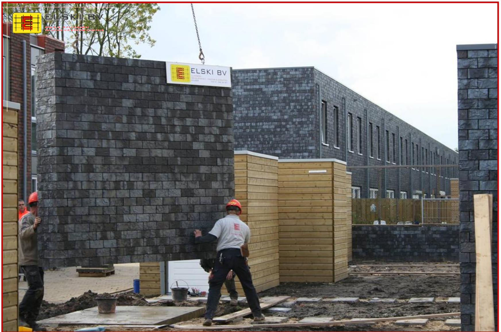
Prefab berging bij 54 laagbouwwoningen te Lent.
