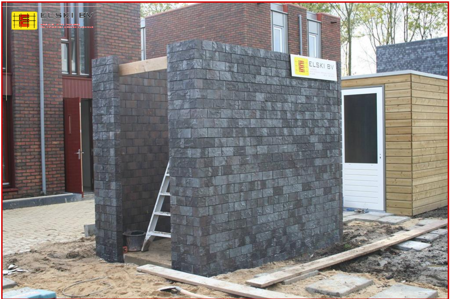
Prefab berging bij 54 laagbouwwoningen te Lent.
